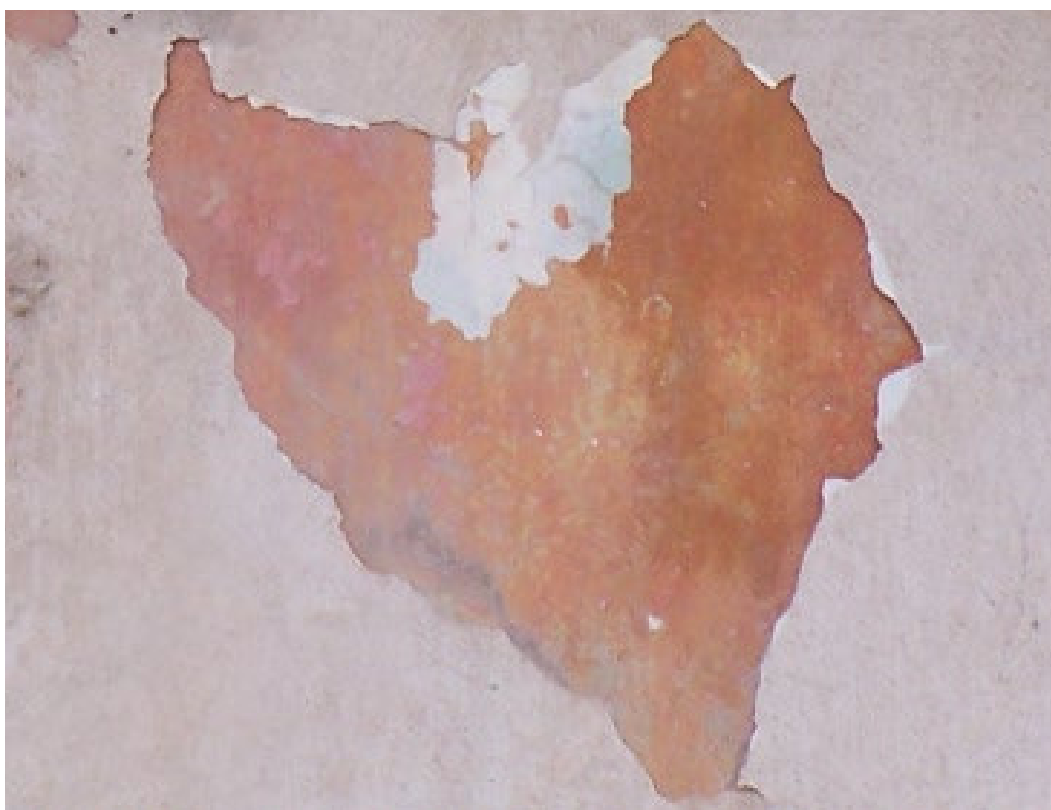
Foto 12. Particolare esterno Palazzo Scarpato
