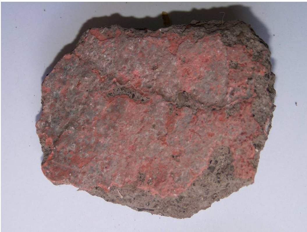
Foto 10. Particolare campione d'intonaco prelevato su Via Marini
