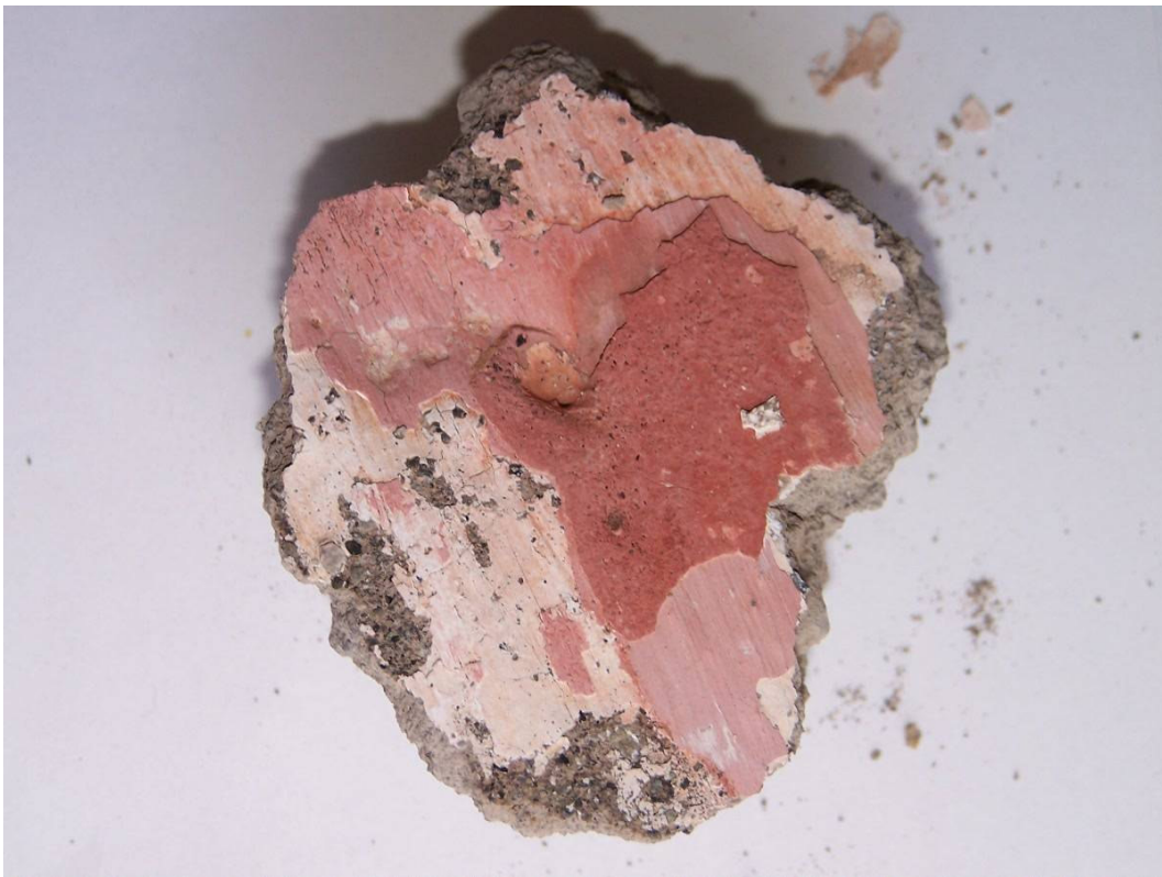
Foto 23. Particolare campione d'intonaco prelevato su Via Santa
