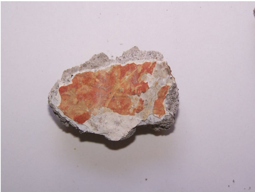
Foto 8. Particolare campione d'intonaco prelevato su Via Marini
